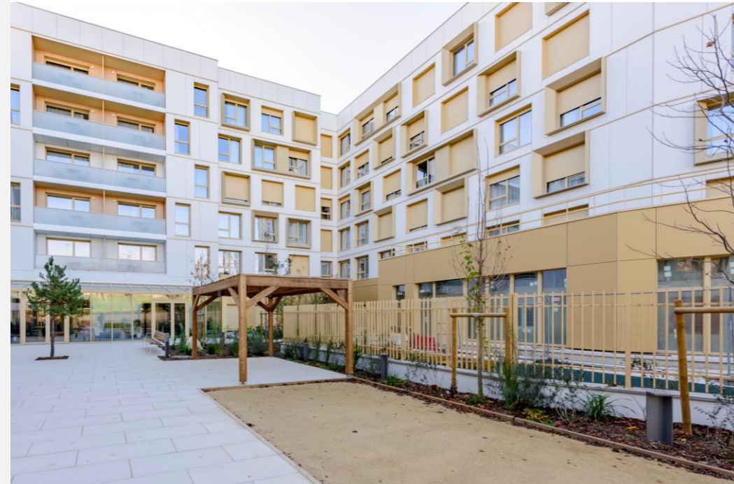
Pôle Intergénérationnel et d'affaire « Henri Barbusse » à Nanterre | QUADRI FIORE ARCHITECTURE , associé M2H ATELIER | Crédit photo : Quadri fiore – m2h atelier
