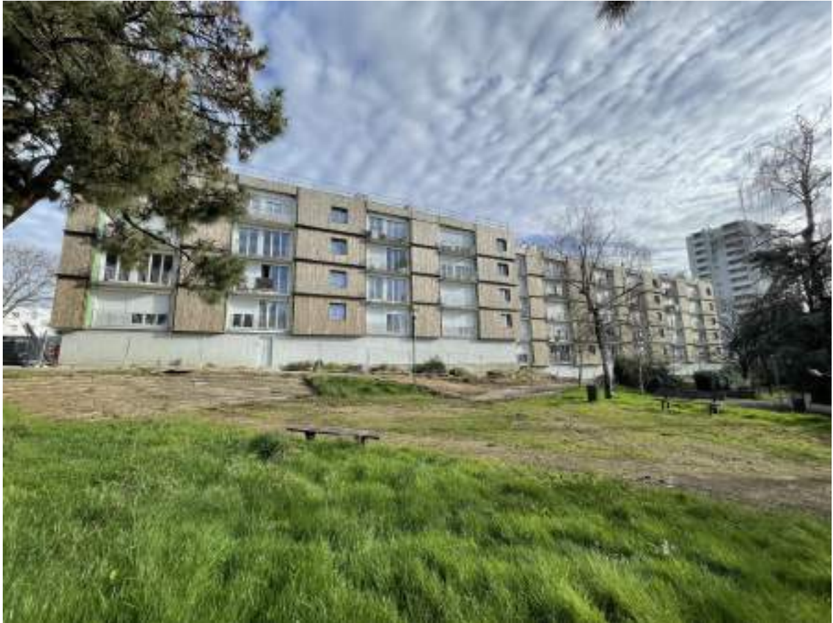
Pose des murs FOB en cours
