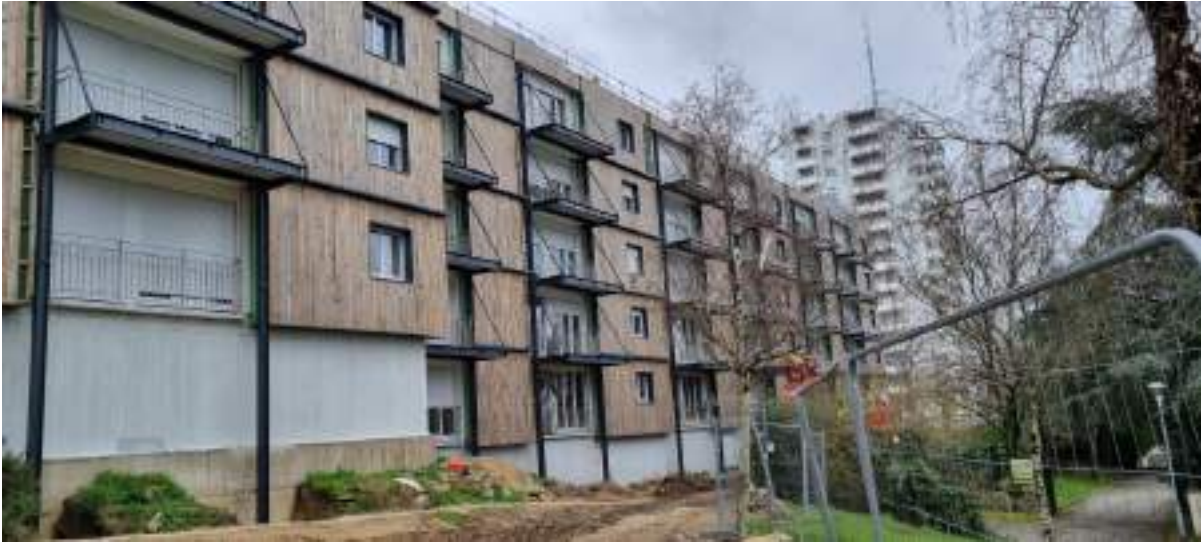
L'agrandissement des balcons en cours
