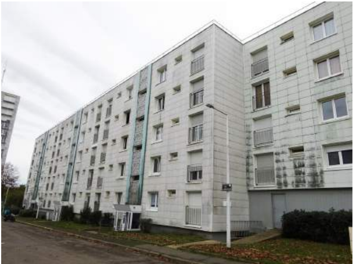
Le bâtiment existant
