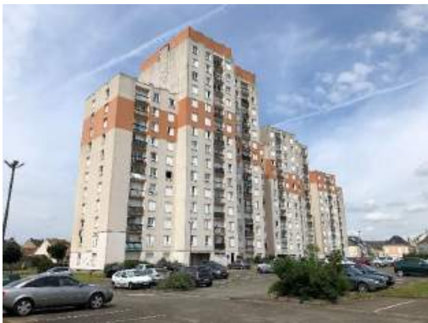
L'immeuble avant intervention
