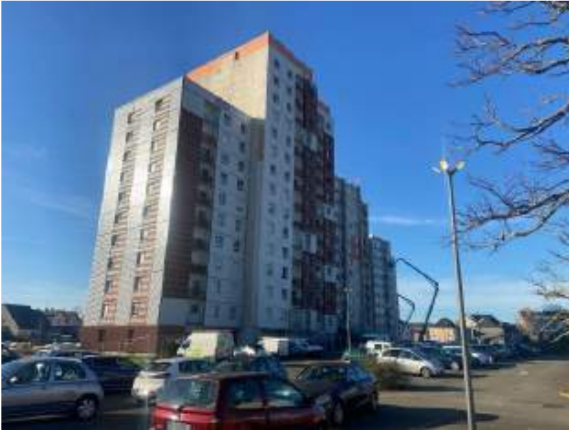
Les travaux sont en cours. Des FOB fabriquées hors site sont en cours de pose.
