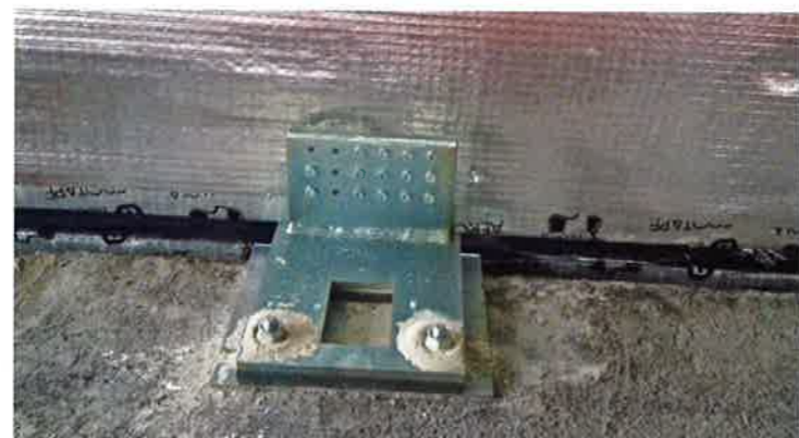
Les ferrures de fixation du Panobloc vues du dessus.
