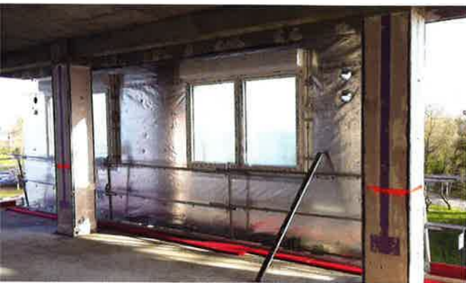
Panneau posé, vu de l'intérieur.
