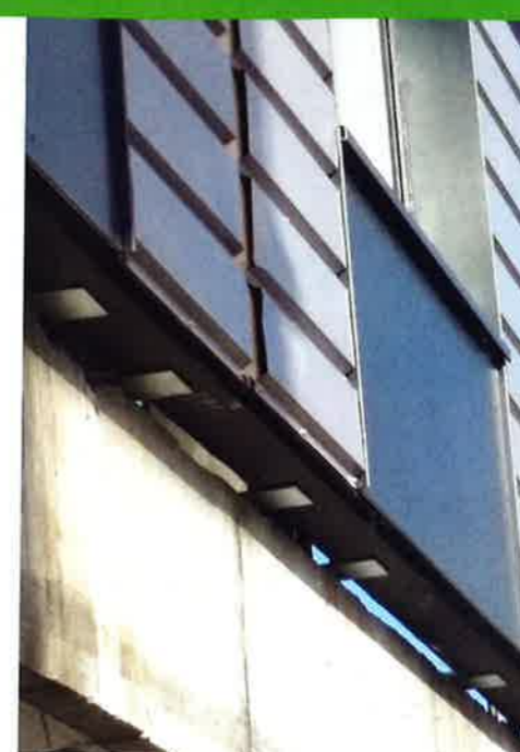
Vue des ferrures au premier niveau.
