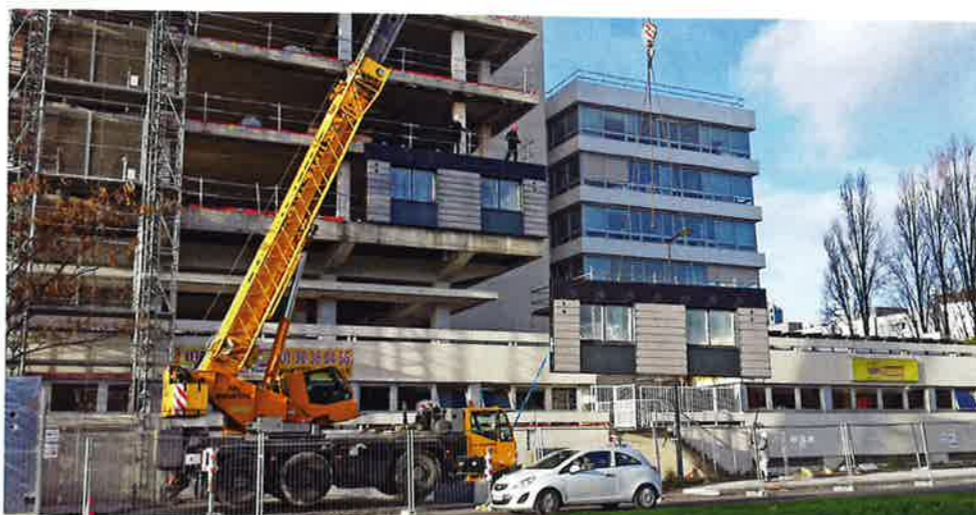
Cette phase s'est déroulée en seulement 4 semaines, dans une zone très passante à l'accès compliqué.
