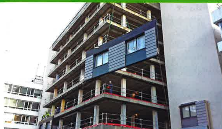
Ils sont ensuite amenés par grutage à l'étage concerné.
