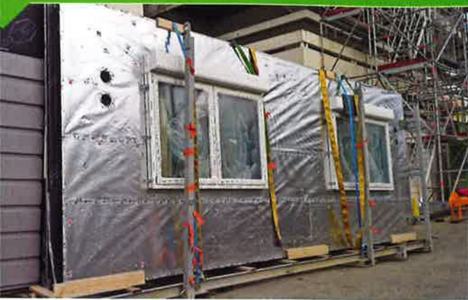
Les panneaux sont entièrement préfabriqués en usine et stockés en flux tendu sur des racks sur le chantier.
