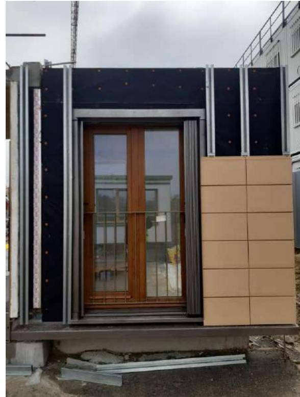
97. Justifier la perméabilité à l'air et l'étanchéité à l'eau et la résistance au vent : réaliser un essai AEV suivant NF EN 13830 avec intégration des cadres aluminium, jonctions verticales et horizontales entre panneaux, etc. La maquette devra comprendre :
