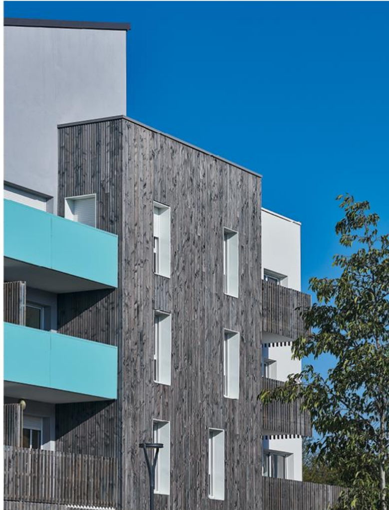
Tremolo gris par imprégnation - My Street : Bouygues immobilier Architecte GOA reprenneur AARBA, Rousseau sas
