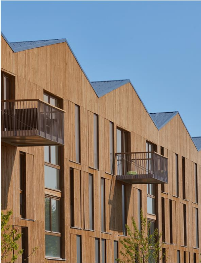
Bardage Melodik claire-voie 22x68 mm, Douglas marron par imprégnation. Erdre et parc 2, Nantes (44). Architecte : Tank architectures (59). Réalisation : Guillet Production et Charrier Bois (85).
