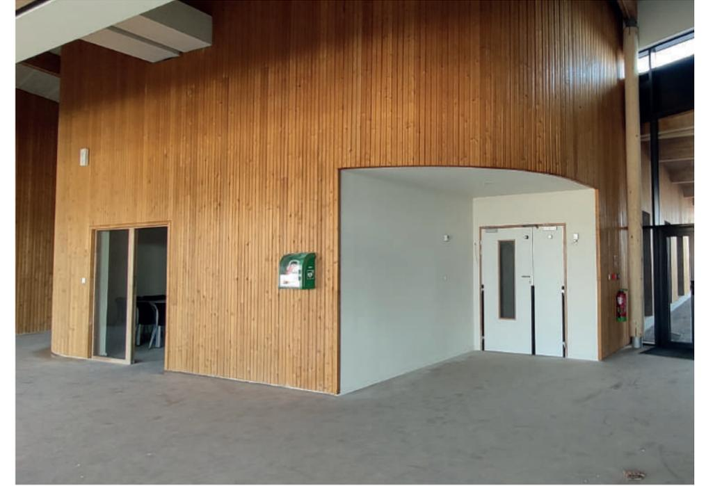
Le vieillissement du bardage est dû aux UV et à l'eau. Selon l'exposition et la configuration, le bois vieillira différemment.
