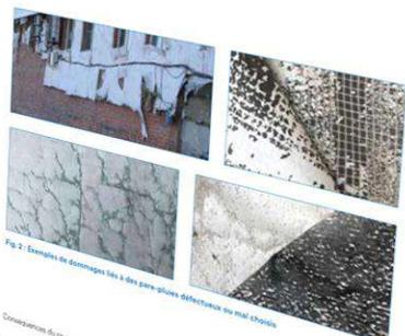
Fig. 2 : Exemples de dommages liés à des pare-pluie détériorés ou mal choisis
