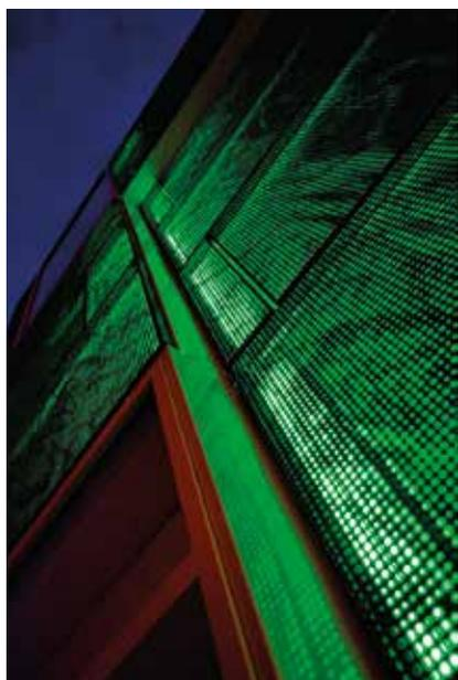
Un pare-pluie adapté permet la pose de bardage à claire-voie ou comme ici, derrière une résille de bois, ou dessous, derrière un bardage métallique perforé. Doc. Salola
