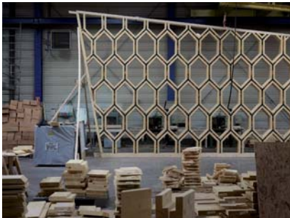
▲ Les alvéoles ont été assemblées en atelier.
