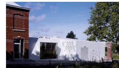
▲ Les façades nord et sud ont été réalisées en béton.
