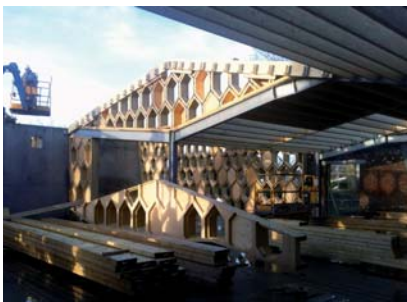
▲ La charpente est en épicéa lamellé-collé.
