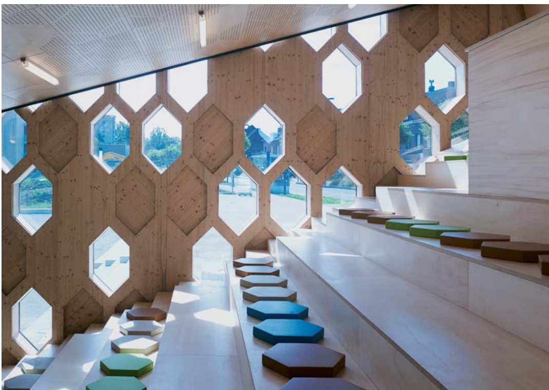
▲ À l'intérieur, les parois de bois ont été recouvertes d'un vernis ignifuge M2 ou Euroclasse C.
